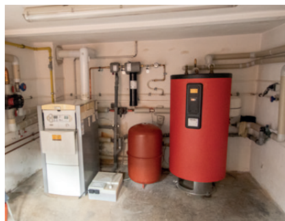
Die alte Heizungsanlage in der Georg-Herwegh-Str. wird ersetzt.
