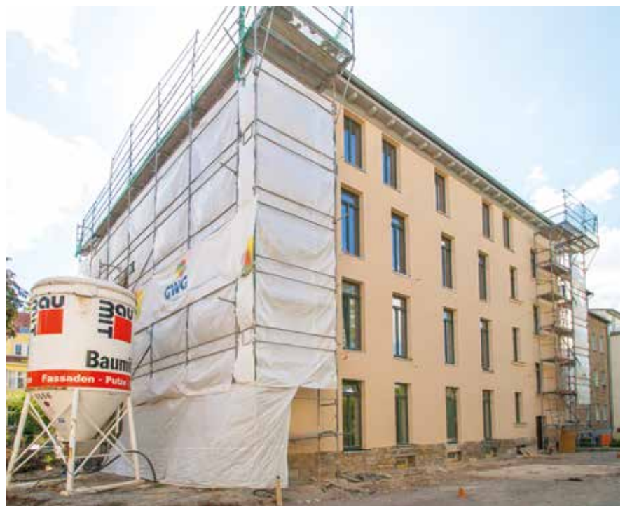
Die erste Fassadenseite in der Schubertstraße 12 ist schon abgerüstet.
