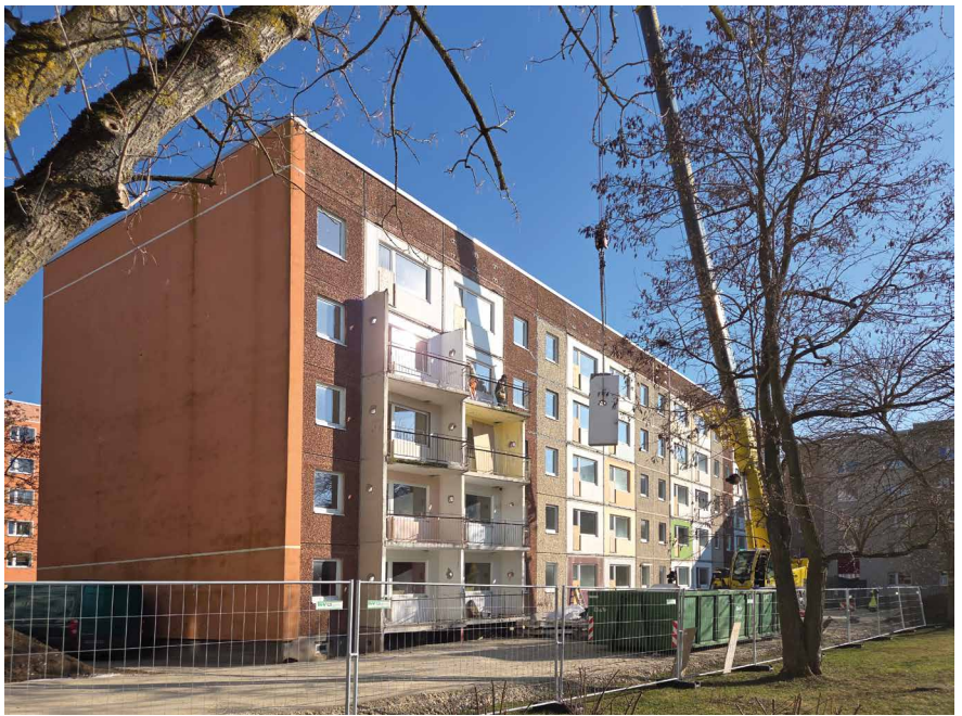
Die alten Balkone wurden Anfang März zurückgebaut.
