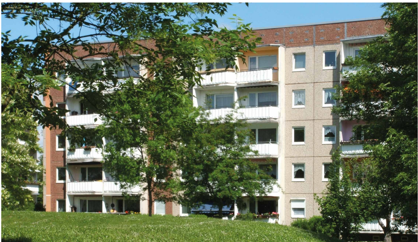
Das Gebäude Moskauer Str. 78-84 wird von Grund auf saniert.
