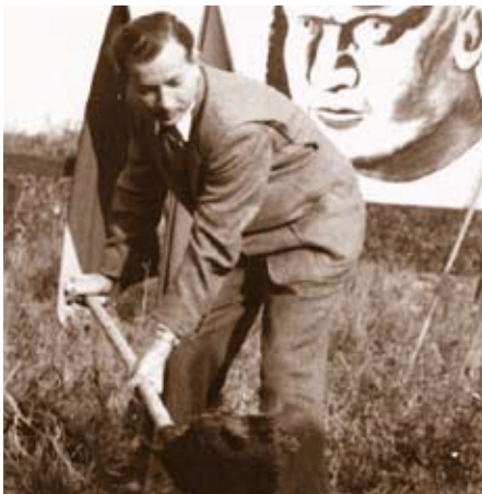
Erster Spatenstich „Am Fuchsberg“
