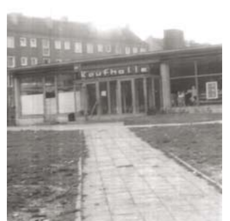
Neubau Kaufhalle „Im Kirschbachtal“
