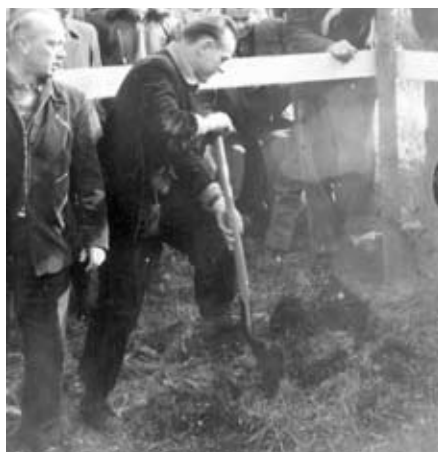
Erster Spatenstich, Schwanseestraße
